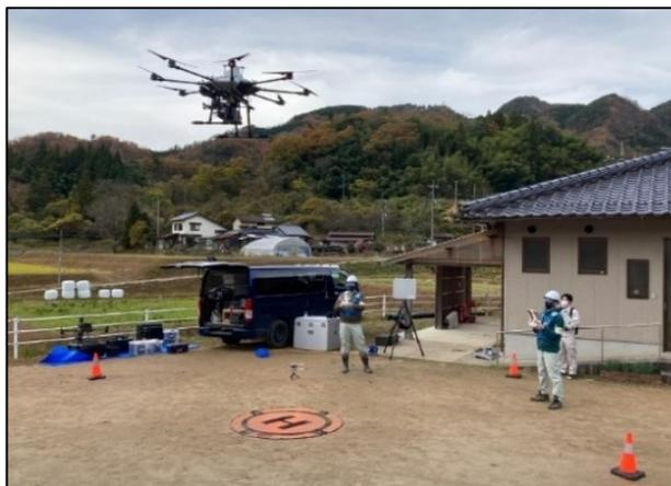
図 IV-13 UAVレーザ測量時の離発着場
